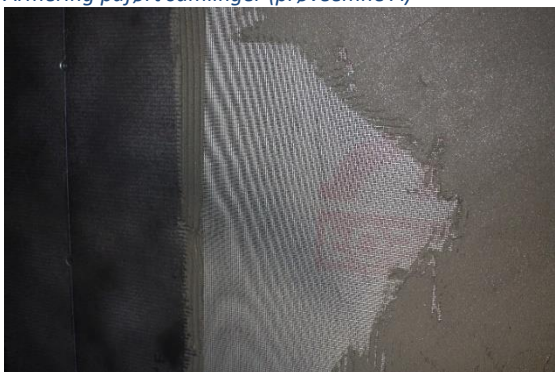
Eksempel på armeringsnet i puds (prøveemne B)
