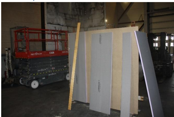
Prøveemne under opbygning
